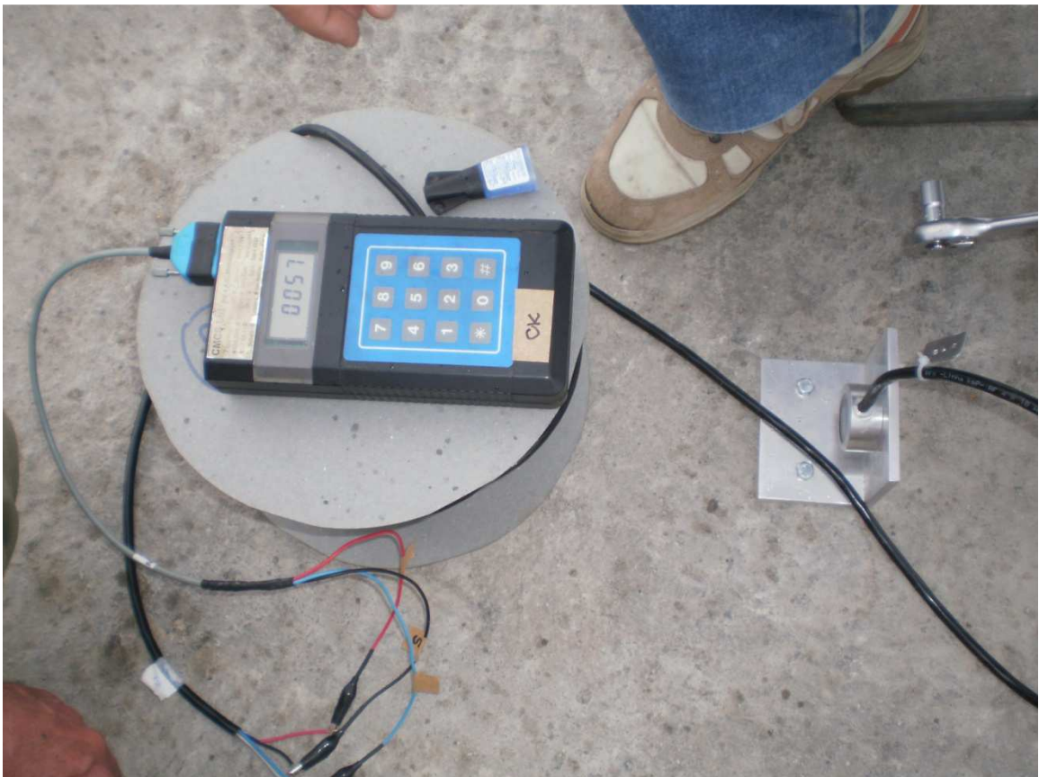
Figura 5. Detalhe da instalação dos eletrônicos.
