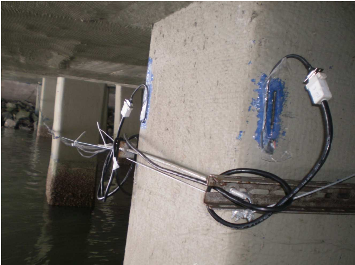
Figura 4. Extensômetros elétricos na estaca 47.
